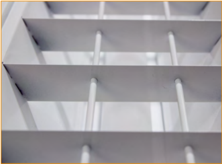
Raster durch Stahlstreben verstärkt und mit dem Leuchtkörper verschraubt
